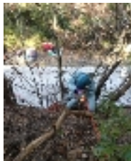
D尾根の作業 細引き丸結びで降りる
