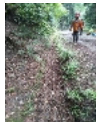
林道側溝の小枝、石、落ち葉を掃除しました 綺麗になった側溝
