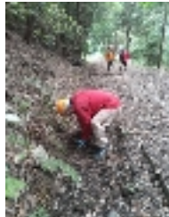
林道側溝の小枝、石、落ち葉を掃除しました 綺麗になった側溝
