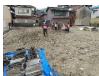
崩したブロックの移動
