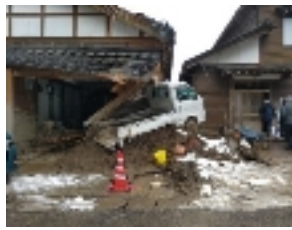
輪島市山本町。山から土石流が流れ込み甚大な被害を受けました。
