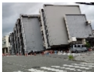
2 人が亡くなった 7 階建てビル基礎部分に残して解体予定。
