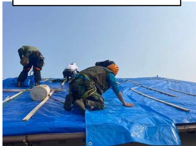
ブルーシート貼り付け作業状況
