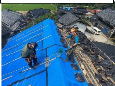
棟瓦を境に双方で確保を取って作業
